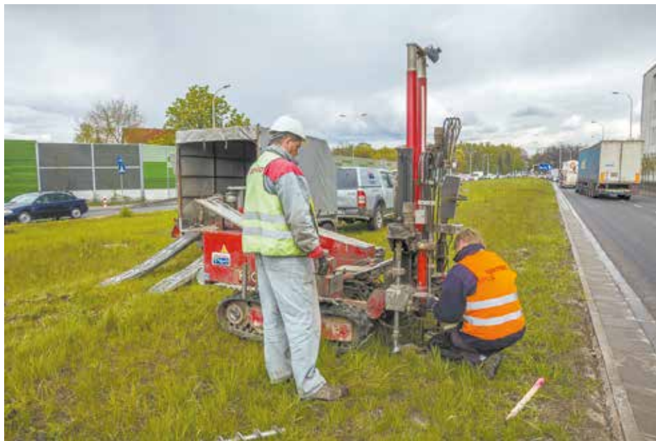
Badania geotechniczne gruntu w miejscu nowych jezdni ul. Marsa
